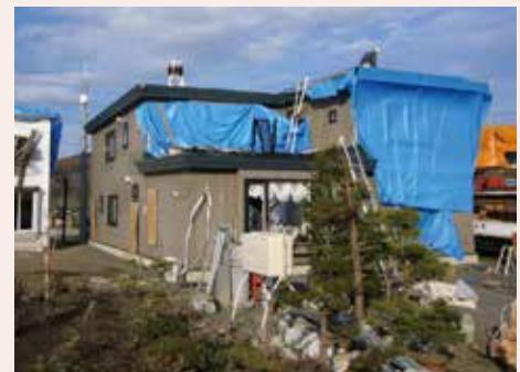
屋根の板金と野地、たるきが飛散
